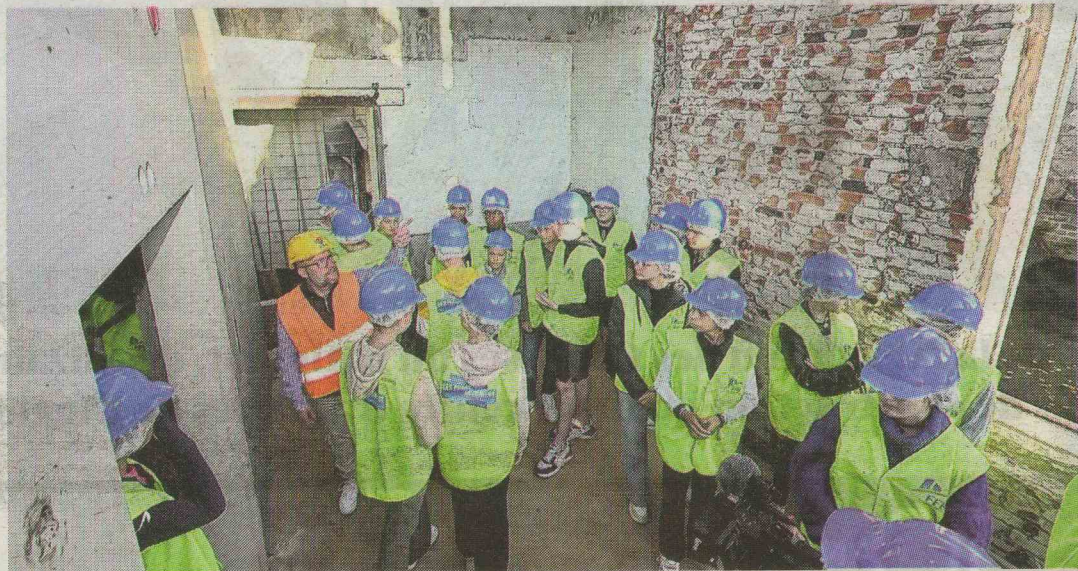
Plusieurs dizaines de collégiens, par groupes, ont visité le site en construction des futures archives de la ville et de la CAE sur le pôle Bragard. Photo Philippe Briqueleur
